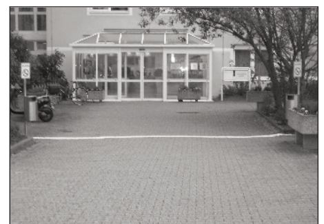
Krankhauseingang in Australien mit 6 Meter Abstandszone zum Eingang. Wann wird das in Österreich eingeführt?
